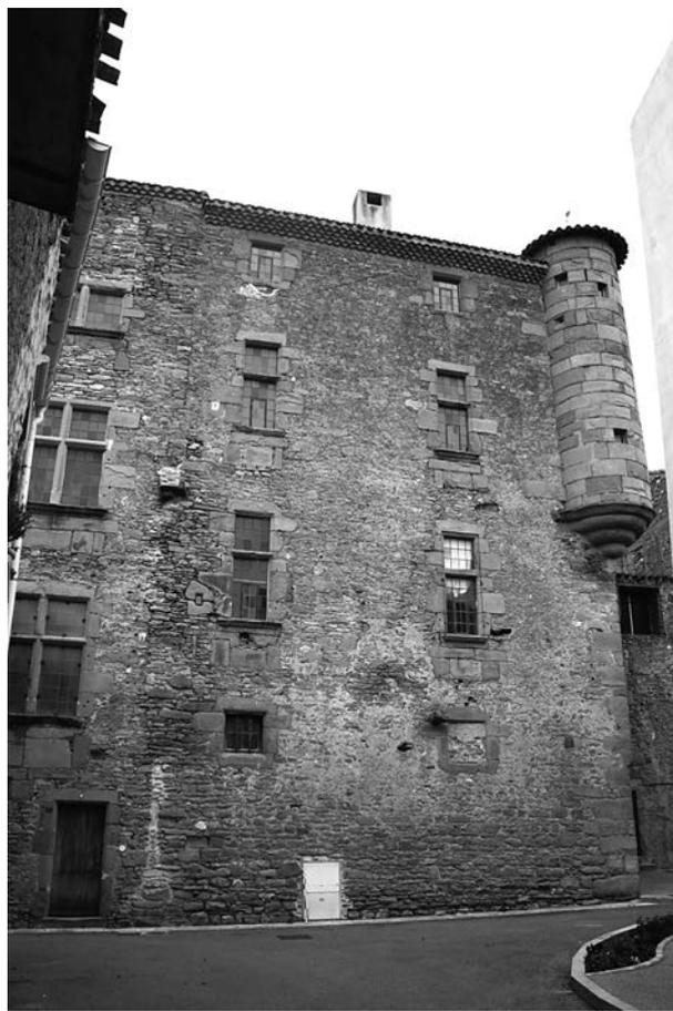
Fig. 28 : Corps de logis du château d'époque moderne, vu depuis l'est. On remarque à gauche la maçonnerie de l'ancien escalier, plaquée postérieurement.
