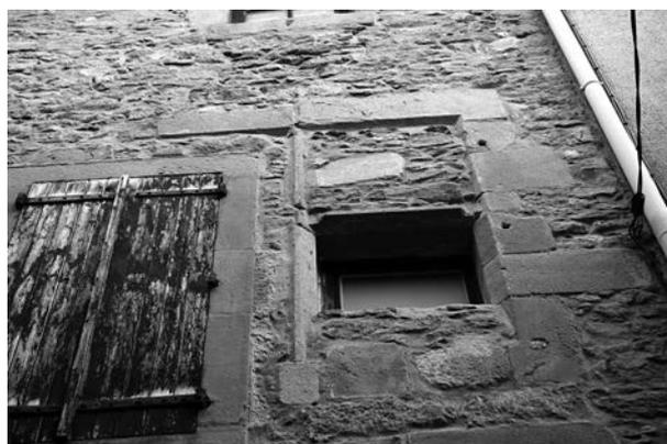
Fig. 33 : Maison du n° 15, rue de la Ville. Détail de la baie à meneau du premier étage partiellement détruite.
