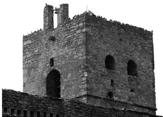
Fig. 16 : Le clocher, vue des murs MR13d et MR14d depuis le nord-est. On remarque les baies en partie murées ainsi que le clocheton.
