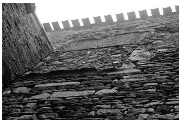
Fig. 17 : Enceinte ouest du noyau castral, mur MR24, baie à meneau murée.
