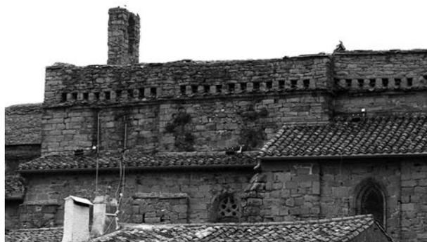
Fig. 11 : Eglise Saint-Sauveur, vue depuis le nord. Au premier plan les chapelles latérales C et D. Au second plan le mur MR19a et son parapet percé d'évacuations pour les eaux pluviales (ancien niveau de défense dérasé).
