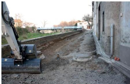
Après le remplacement des branchements plomb, la commune a procédé à la réfection de la rue des Caves-Est, de la chaussée et du pluvial du quai de l'argent double (avec décaissement important), de la rue de la ville (avec réfection de certains caniveaux défectueux), de l'Impasse de l'Église, de la rue St Martin et de la rue de la Beauté. C'est le Syndicat Intercommunal de Cyclindrage (SIC) qui a effectué ces travaux.
